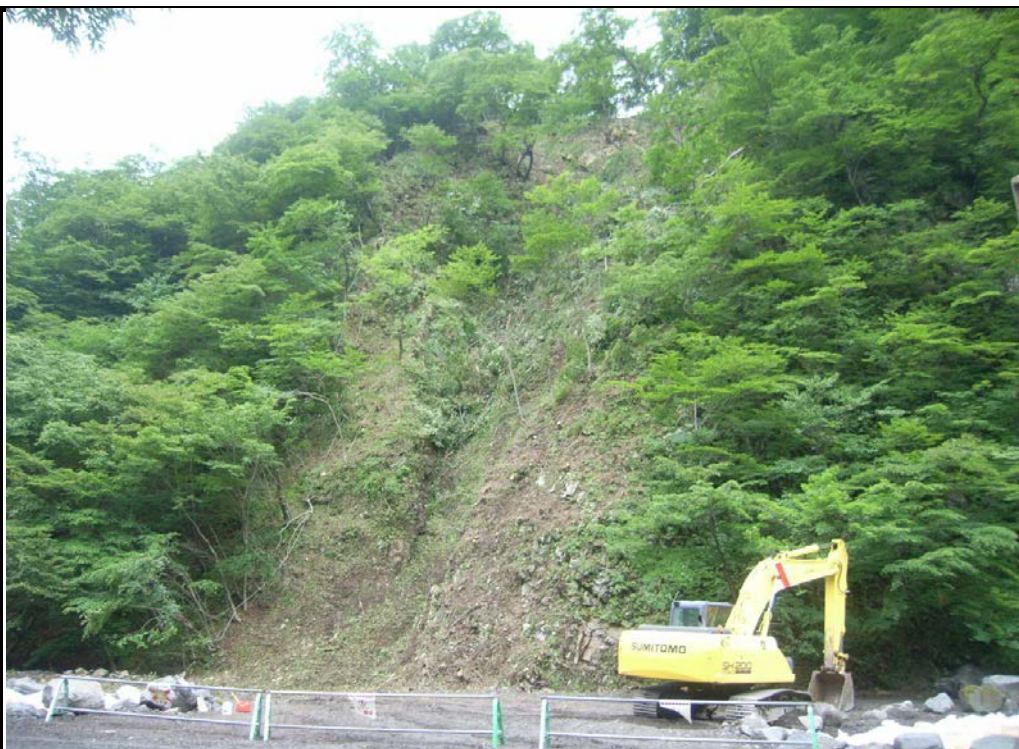
山腹工施工範囲の伐採状況（平成25年6月末）
