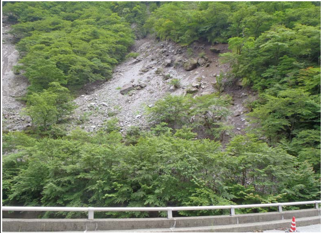
工事着手前全景
