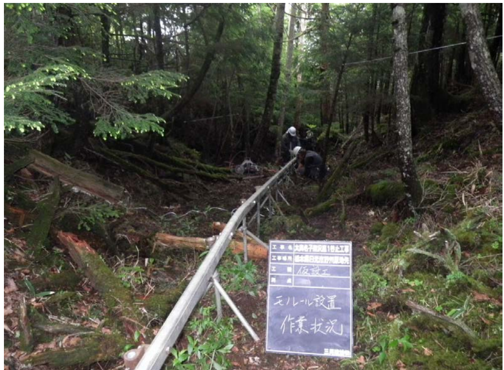
仮設工（モノレール設置）
