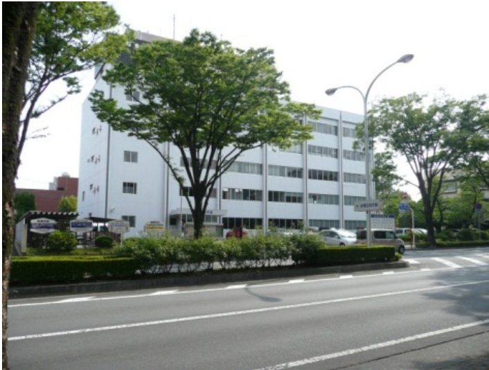
前橋地方合同庁舎
