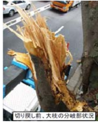
写真-6 枝落後の状況
