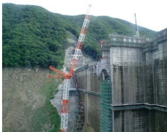
写真-4 施工状況（2）
