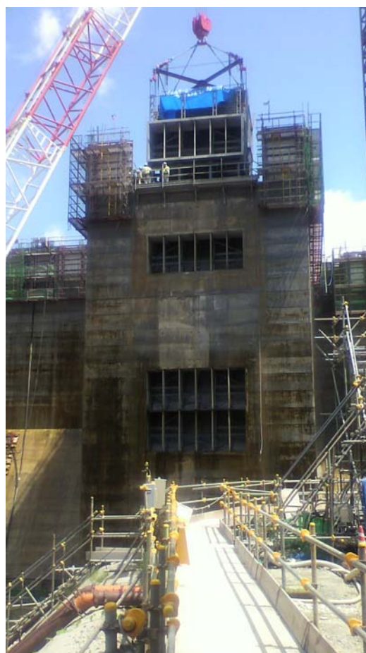
写真-3 施工状況（1）
