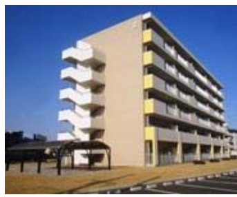
公営住宅整備事業(茨城県)
