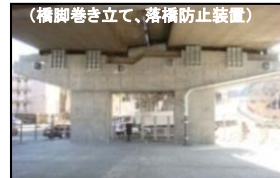
(橋脚巻き立て、落橋防止装置)
