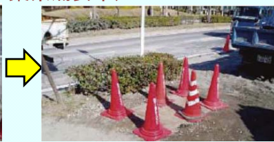
マンホールを切断し簡易覆蓋を設置
