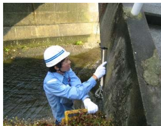
自治体管理橋梁の点検状況（技術的助言）
