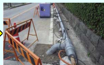
臨時の仮設配管を設置
