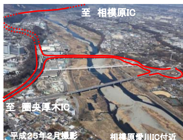
平成25年2月撮影 相模原愛川IC付近
