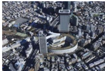
大橋地区市街地再開発事業(目黒区)
