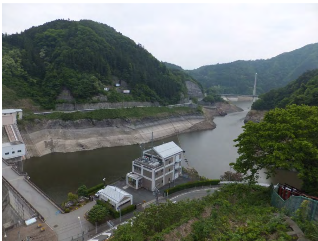
合角ダム（平成25年5月19日撮影）
