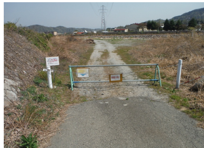
舞鶴橋左岸下流 車止め設置状況 を確認
