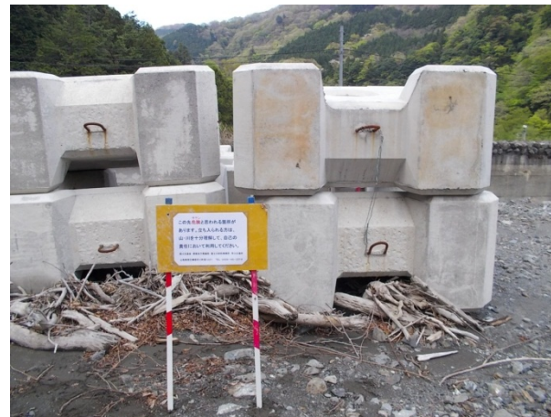
春木川 根固ブロック仮置場に 注意喚起看板を設置
