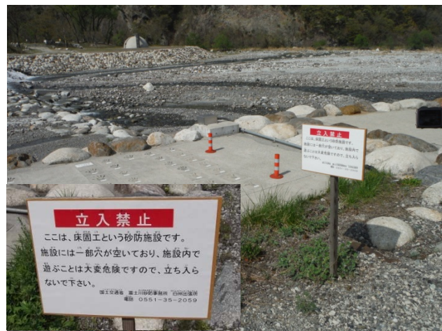
大武川第50床固 注意喚起看板 設置状況を確認
