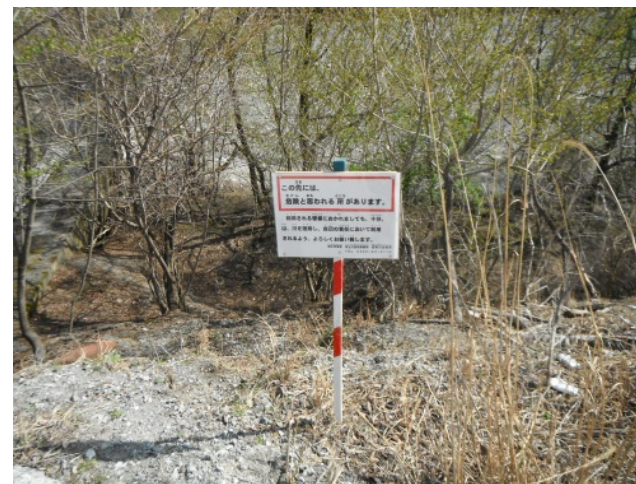
唐沢砂防堰堤 注意喚起看板 設置
