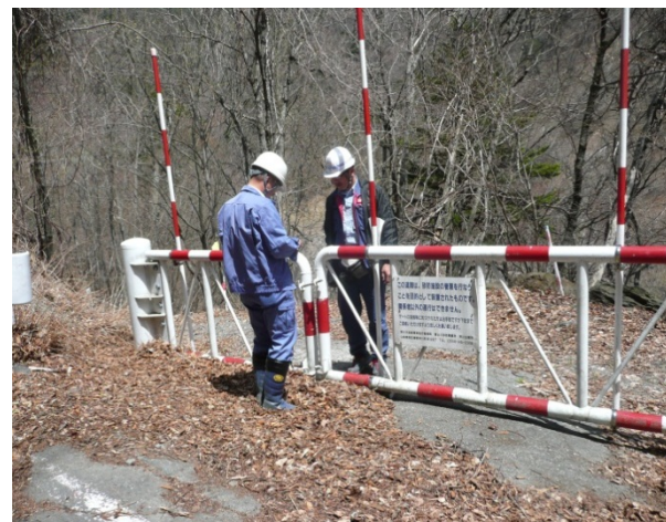
野呂川工事用道路 点検状況
