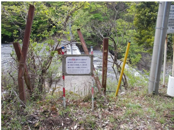
栃原堰堤 袖部 立入痕跡部に 注意喚起看板を移設
