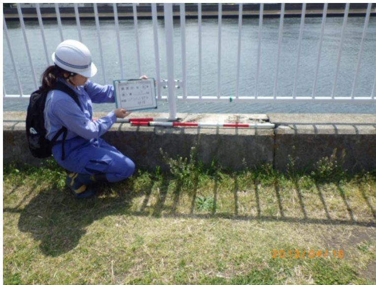
水際の手すりに異常がないか点検(鶴見川)
