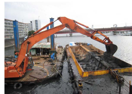
鶴見川下流部河道掘削状況
