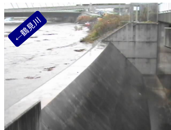
洪水調節状況（平成22年12月3日）
