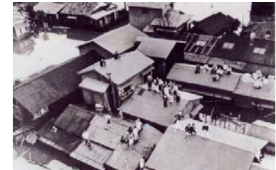
1958年(昭和33年)台風22号(狩野川台風) 床上・床下浸水 20,000戸以上
