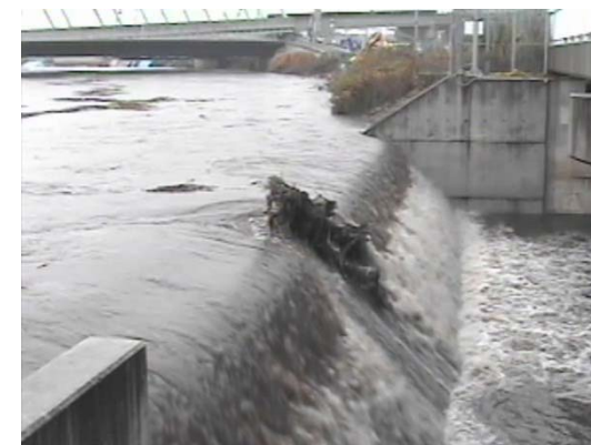
川和遊水池越流状況(平成22年12月3日)
