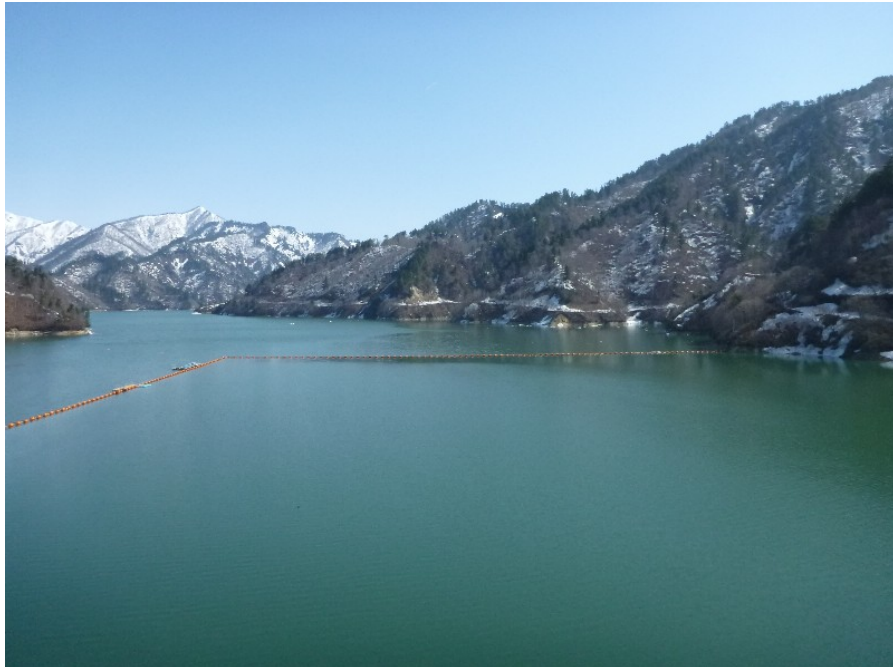
矢木沢ダム(平成25年4月15日撮影)
