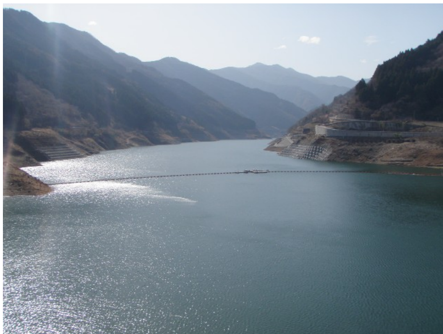
滝沢ダム(平成25年4月9日撮影)
