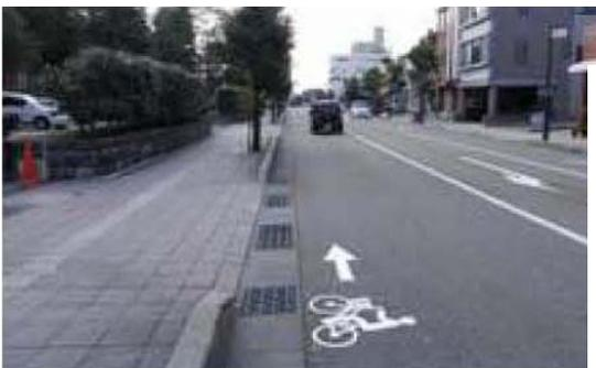
自転車と自動車が車道で混在。自転車の通行位置を明示し、自動車に注意喚起するため、必要に応じて路肩のカラー化、带状の路面表示やピクトグラム等を設置
