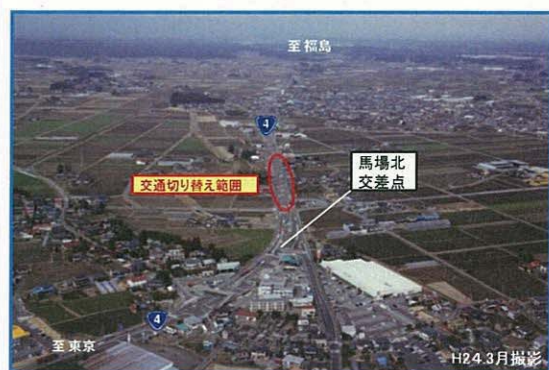
切り替え箇所付近（福島方面を望む）
