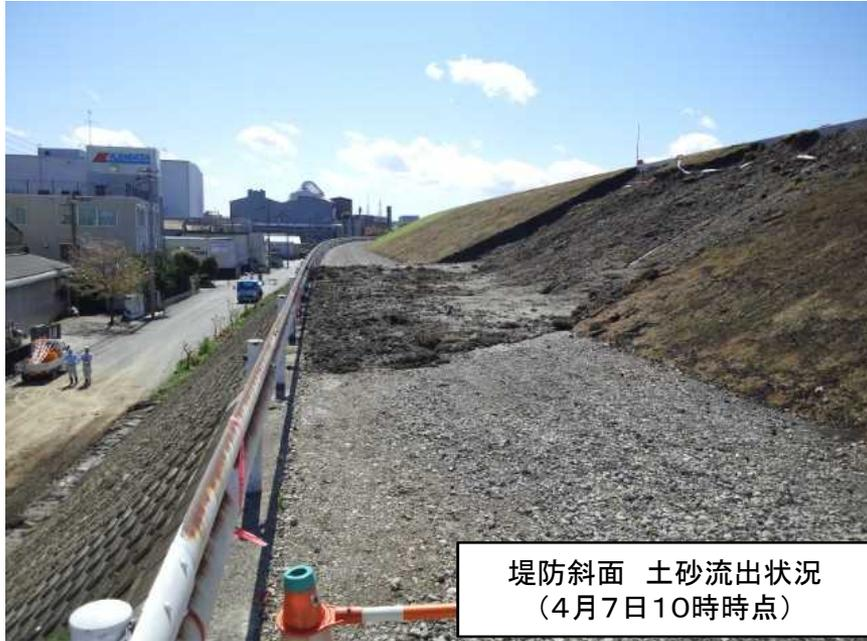
堤防斜面 土砂流出状況
