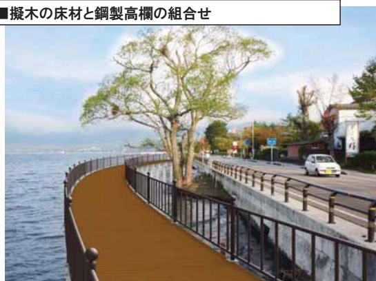
■擬木の床材と鋼製高欄の組合せ
