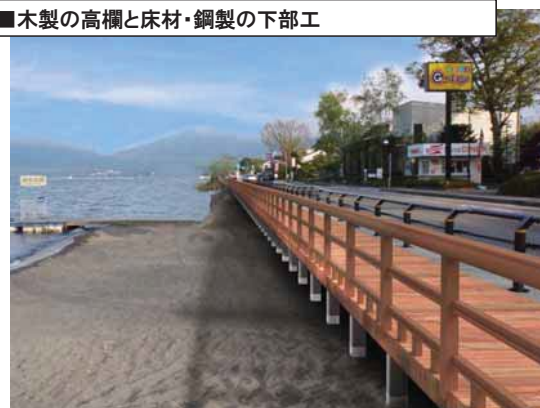
■木製の高欄と床材・鋼製の下部工
