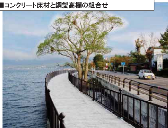
■コンクリート床材と鋼製高欄の組合せ
