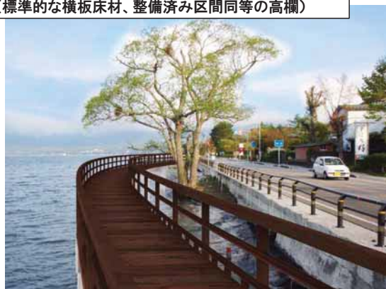
■木製栈橋① (標準的な横板床材、整備済み区間同等の高欄)
