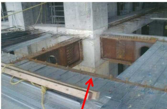
2階床開口部状況
