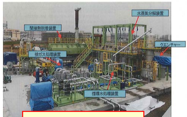
無害化処理施設(テント設置前)
