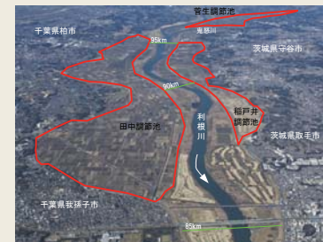
▲鬼怒川合流点付近に整備している洪水調節施設(田中調節池、菅生調節池、稲戸井調節池)
