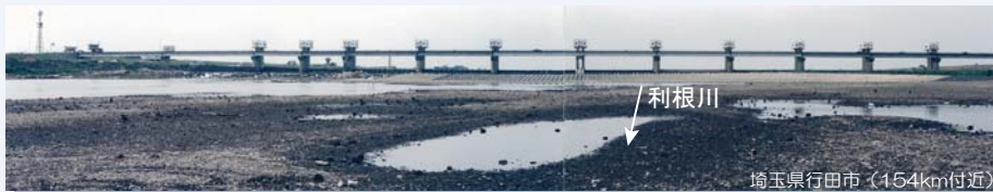
▲渇水時の利根大堰下流の状況(平成8年9月上旬)
