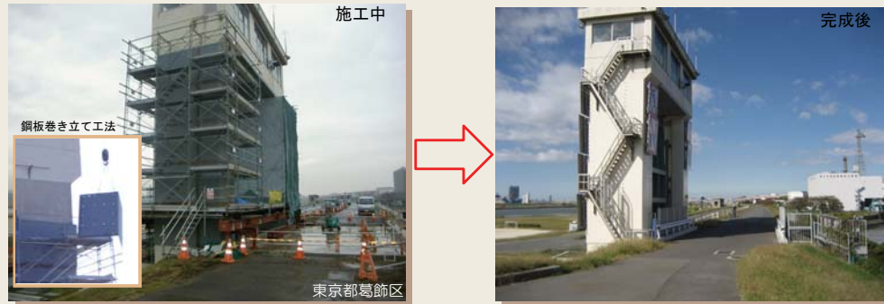
▲耐震対策の事例(荒川水系荒川、綾瀬水門)
