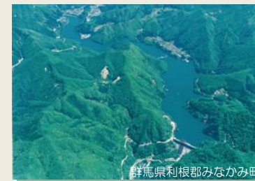
▲利根川上流部に整備された洪水調節施設(藤原ダム)
