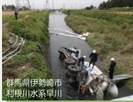
群馬県伊勢崎市 利根川水系早川 ▲水質事故時における対策状況
