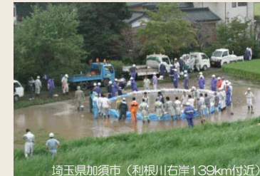
▲平成13年9月 台風15号出水に伴う漏水状況
