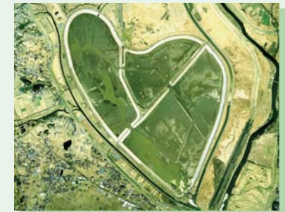
▲干し上げ実施中の渡良瀬貯水池
