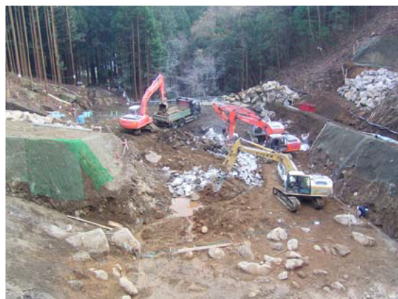
工事施工中①
