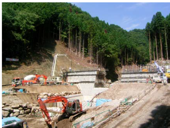
工事施工中②
