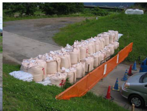
右岸開口部大型土嚢積み
