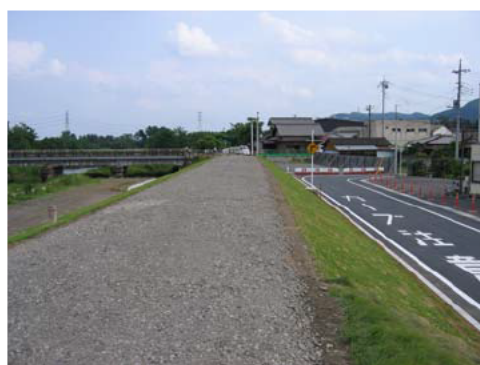
境野築堤護岸完成
