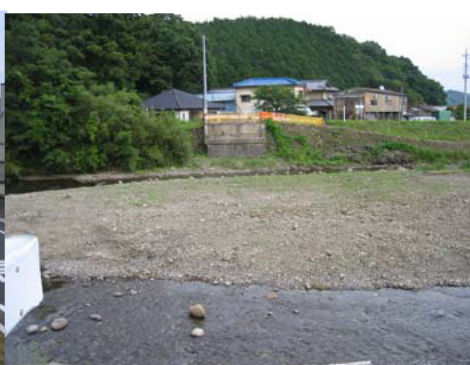
旧両国橋撤去後状況
