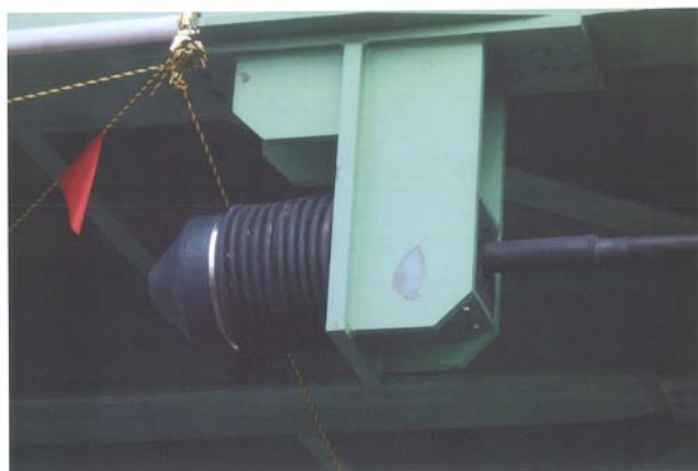
落橋防止装置損傷状況
