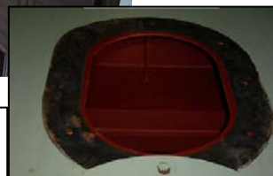
出入用マンホール
