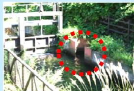
水路が分流する直前に設けられた施設。特徴的な構造で水路内の乱流を防ぎ、下流への公平な分配に寄与している
