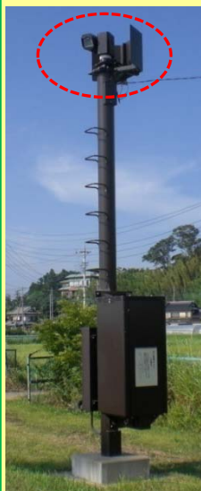
CCTVカメラ (イメージ)
