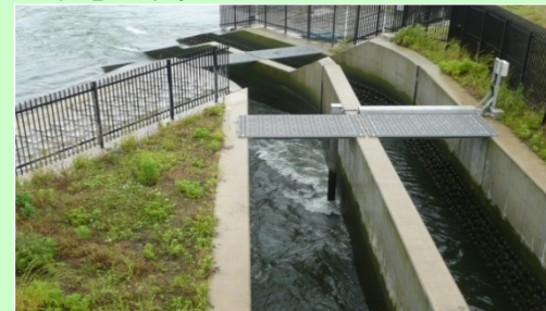
魚道下流側通水状況
