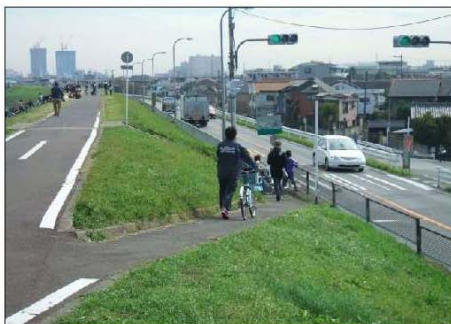
傾斜が急で、手すりが無いため不便なスロープです。
