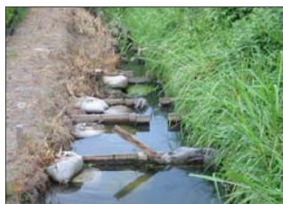
自治体による魚道整備(水路)
