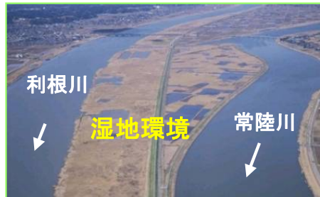
②利根川:河口堰周辺
