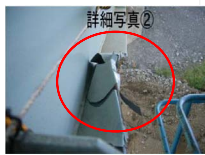
桁損傷状況
