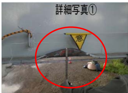
桁損傷状況
