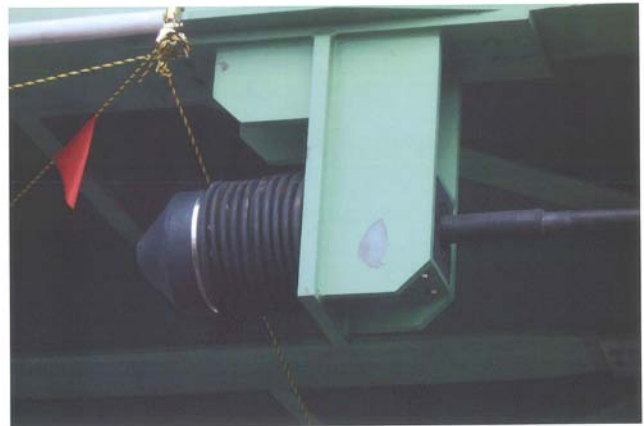
落橋防止装置損傷状況
