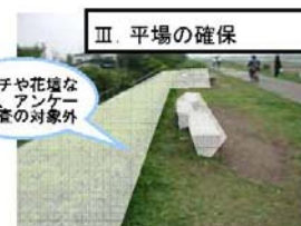
堤防の一部を拡張し、平場を確保
