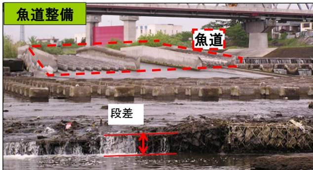
段差が生じて、魚がのぼりにくい状況
