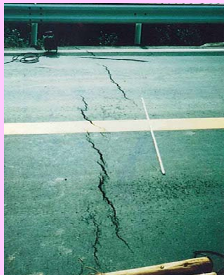
国道462号等の道路に発生した亀裂
