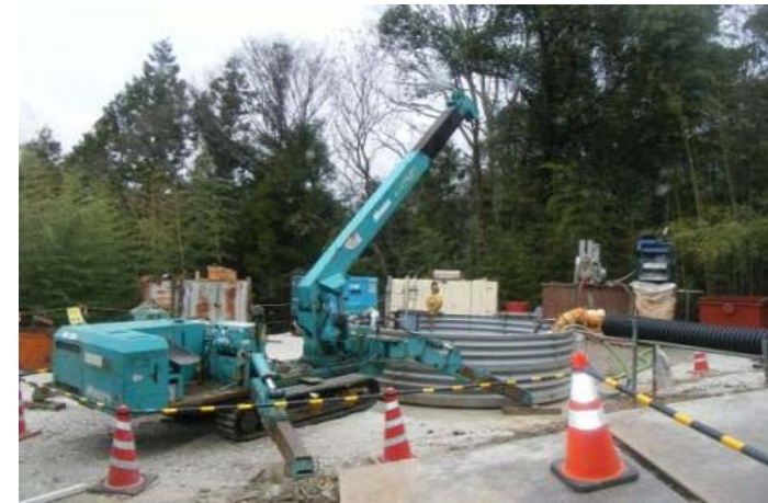
しゅうすいせい 集水井工事(平成23年度)
