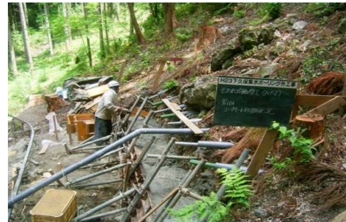
横ボーリング工事(平成23年度)
