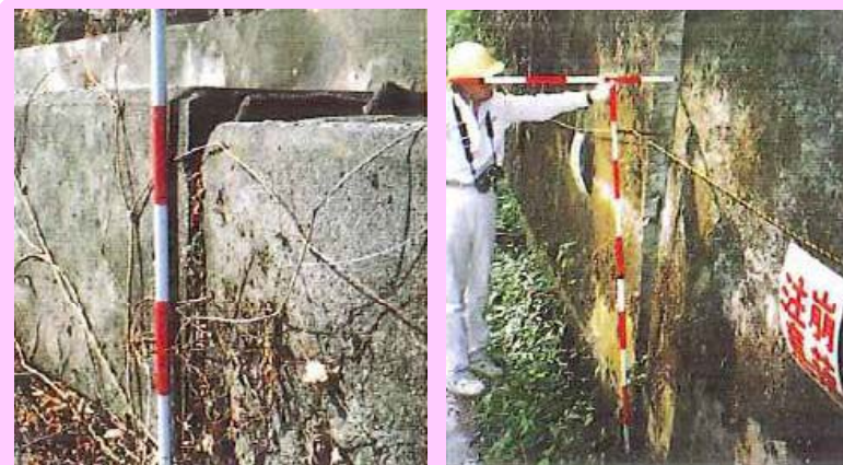
擁壁に発生した亀裂や傾き
