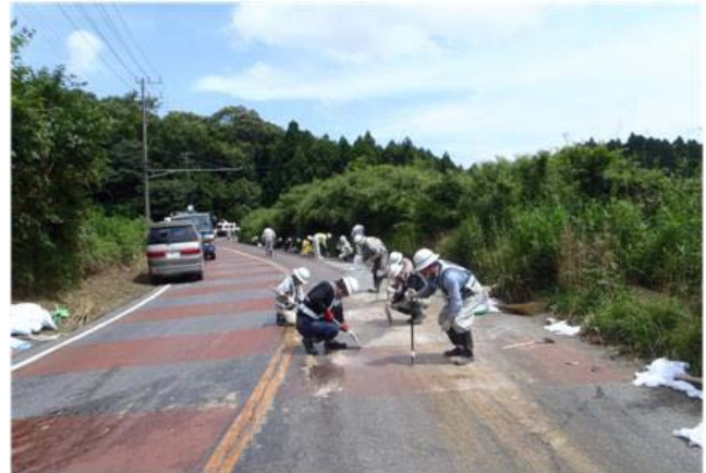
薬液漏出状況
