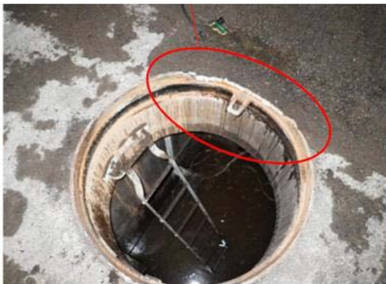
マンホール受枠損傷状況
