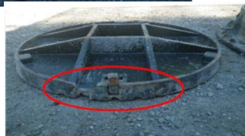
マンホール蓋損傷状況
