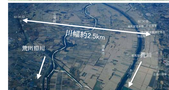
◆熊谷付近（62.0k付近）の広大な高水敷
