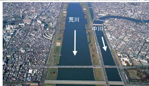
◆放水路区間の状況（7.0k付近）
