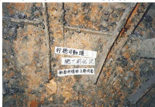
平成4年当時（ゲートの腐食状況）
