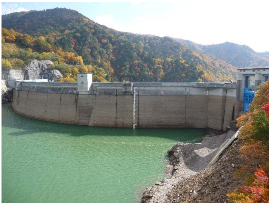
矢木沢ダム（平成２４年１０月２９日撮影）
