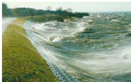
今年6月の台風においては、湖心観測所(霞ヶ浦の真ん中)で風速毎秒24.1m(南南西)の風を記録し、最大波高2.24mの波浪が発生しましたが、離岸堤によって1.0m(試算値)程度、波高を低くすることができます。なお、常陸川水門によって利根川からの逆流を防いだことにより、霞ヶ浦の水位を約40cm低くしたこととあわせると、霞ヶ浦沿岸部では約1.4mの水位低減がなされました。
