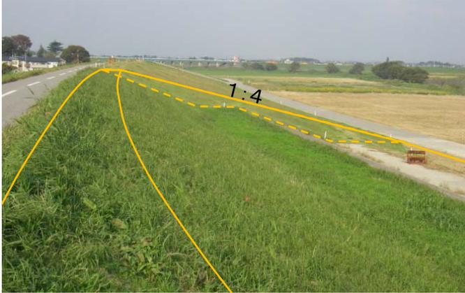
⑤上吉妻地区築堤工事の終了点部(既設の4割堤)から下流へ施工箇所を望む 【春日部市上吉妻地先】
