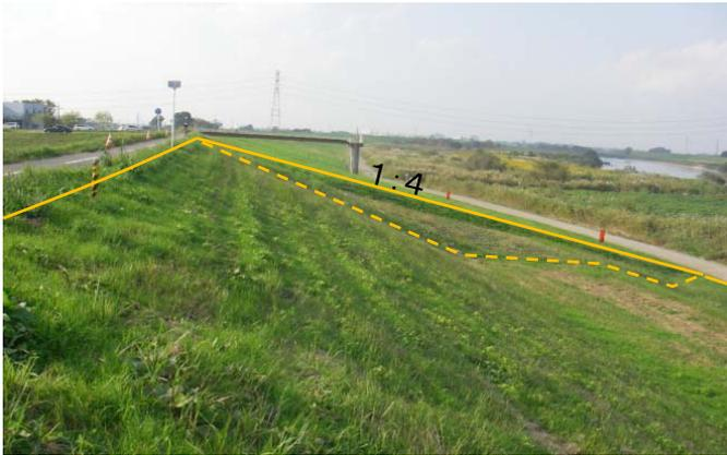
⑦宮前上地区堤防整備工事の終了点部(既設の4割堤)から下流へ施工箇所を望む 【杉戸町宮前地先】
