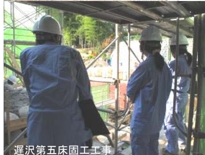
遅沢第五床固工工事
