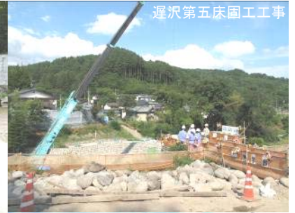
遅沢第五床固工工事
