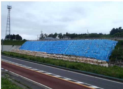
被災箇所である国道4号
