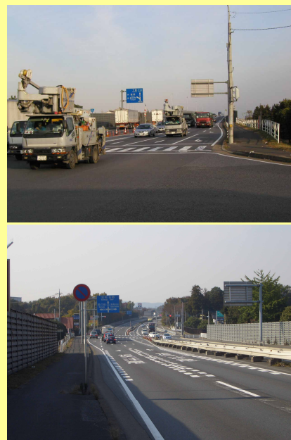
国道50号大平町鯉ヶ島交差点付近 【整備後】
