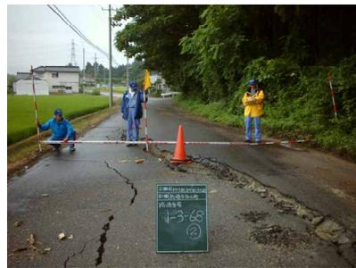
＜柏崎市道 4-3-68 号線：路面のひび割れ、段差＞
