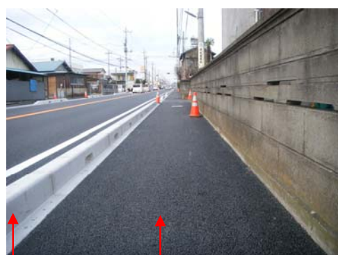
側溝の暗渠化 段差のフラット化
