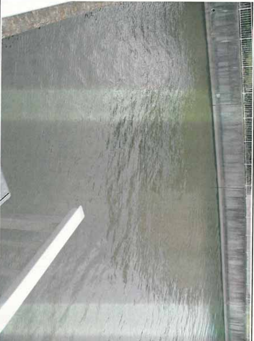
西浦右岸47.25km+100m 備前川水門裏 レベル2～3 水門は上がっていた
