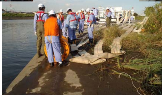
排水ポンプ投入準備
