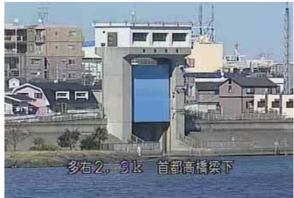
羽田第一水門の通常時状況 (10/4 14:00頃 河川管理用カメラ画像)
