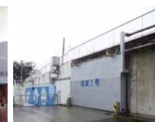
須賀周囲堤陸閘 外観
