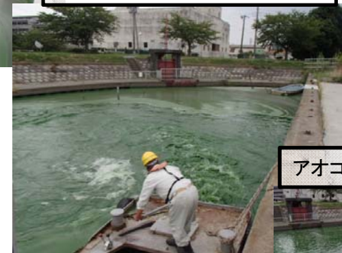
作業船によるアオコ攪拌作業④
