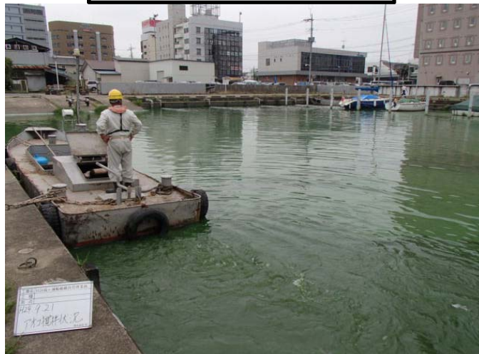
作業船によるアオコ攪拌作業②
