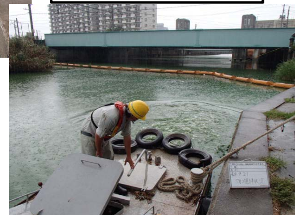
作業船によるアオコ攪拌作業⑤
