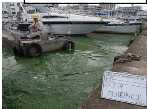
作業船によるアオコ攪拌作業③
