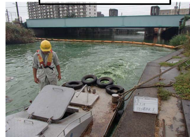
作業船によるアオコ攪拌作業⑤
