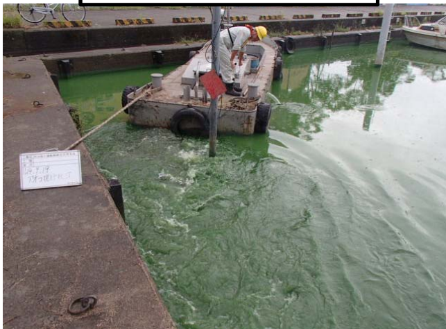
作業船によるアオコ攪拌作業②
