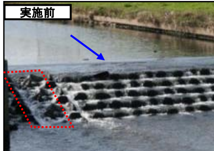
床固め工改良 1箇所
