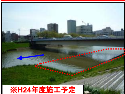
橋梁部のアンダーパス 2箇所
