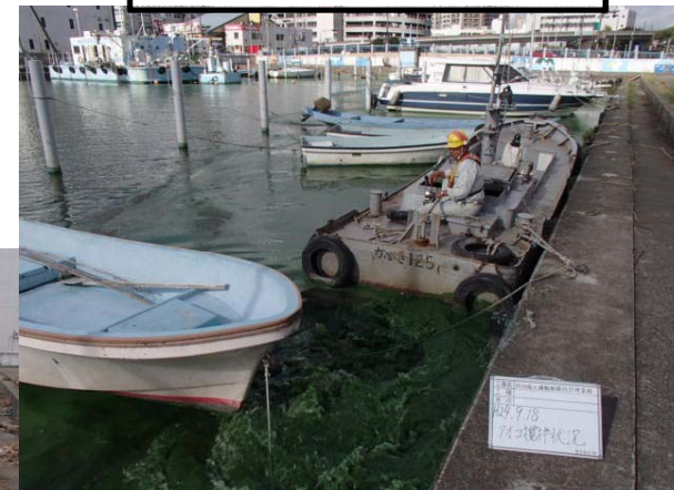
作業船によるアオコ攪拌作業⑤
