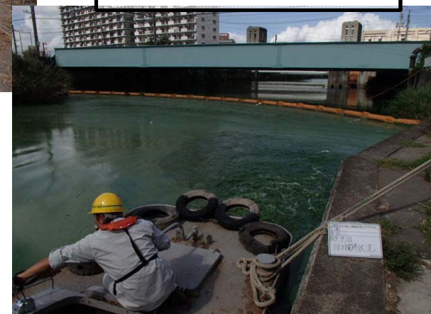
作業船によるアオコ攪拌作業⑤
