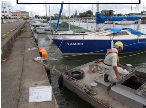
作業船によるアオコ攪拌作業①
