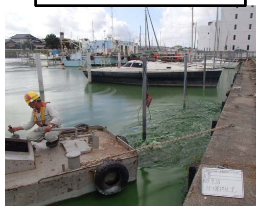
作業船によるアオコ攪拌作業③
